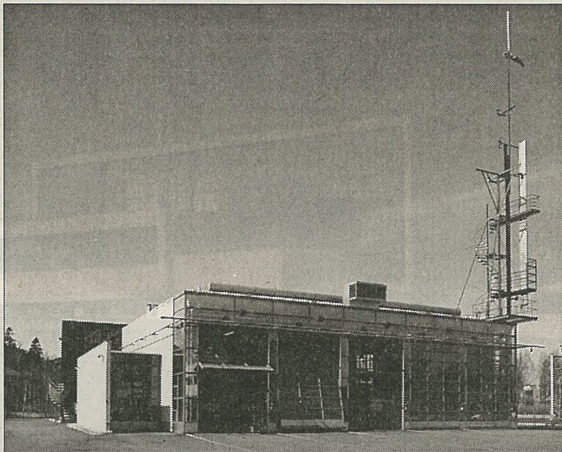
Erkki Kairamo: Feuerwehrgebäude in Niittykumpu, Espoo, 1994. (Bild Affentranger)
